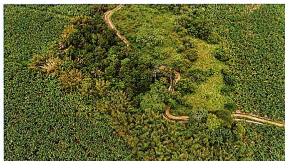
Figura 4. Reconocimiento aéreo del drenaje, vegetación de ronda y vía interna de acceso.
