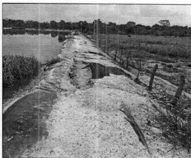
Registro Fotográfico En visita de campo el 24 de Julio de 2019 Fallas Lagunas de Oxidación Municipio de Fundación.
