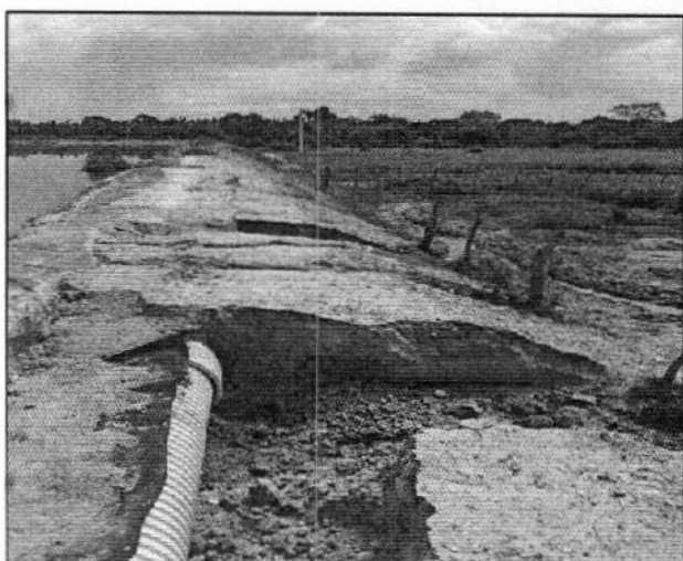
Registro Fotográfico En visita de campo el 24 de Julio de 2019 Fallas Lagunas de Oxidación Municipio de Fundación.
