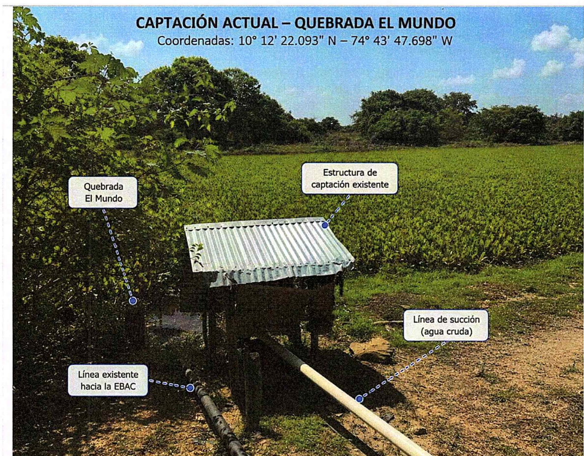
Figura No. 4. Infraestructura existente asociada al punto de captación sobre la Quebrada El Mundo. Fuente: Registro fotográfico de visita de inspección ocular realizada por CORPAMAG, 24 de junio de 2026.
