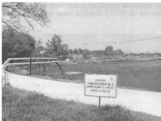
Imagen 3. Lagunas anaerobias metanogénicas
